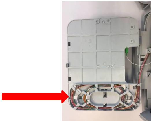
Assemblare sulla/sulle fibre da terminare un connettore SC/APC montabile in campo e terminare la fibra sul manicotto SC/APC della rastrelliera di terminazione lato destro con un criterio di riempimento che va da destra verso sinistra e dal basso verso l'alto.
