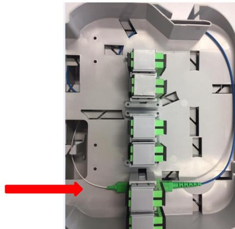
Inserire la bretella di collegamento OLO per la cessione della fibra orizzontale all'interno del PTE attraverso l'imbocco dedicato alle bretelle di collegamento OLO.
