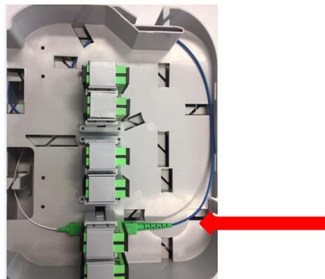
Una volta terminato il cablaggio, fissare la bretella utilizzando un giro di nastro adesivo in velcro e una fascetta in dotazione nel kit.
