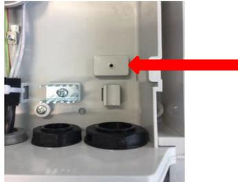
Fissare il cavo utilizzando una delle fascette in dotazione nel kit
