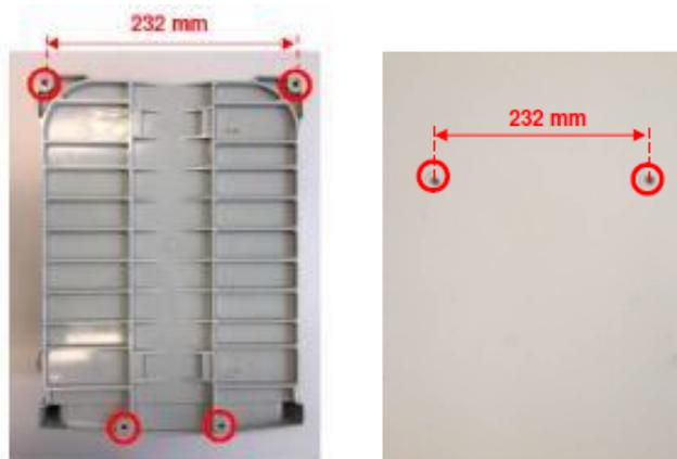
Fissare il PTE in posizione utilizzando le viti in dotazione (senza serrarle).
