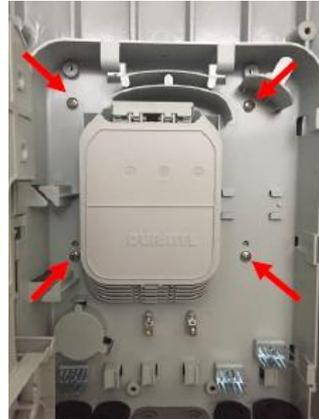
Nel caso di installazione ad uso ibrido della terminazione ottica ( PTE + Terminazione in rame ) il PTE (Optical Core) deve essere posizionato nella parte alta della colonnina tramite una staffa da fissare con asola rivolta verso l'alto con 2 viti M5 in dotazione nel kit.
