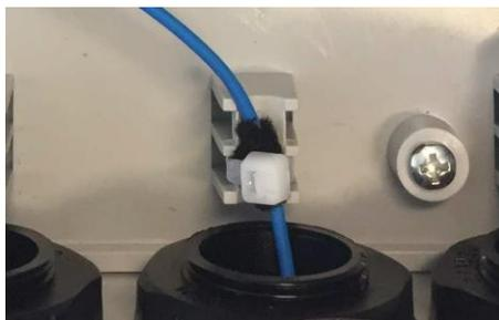
Selezionare la fibra del cavo multifibra o il cavetto singolo e assemblare sulla fibra da terminare un connettore SC/APC montabile in campo.
