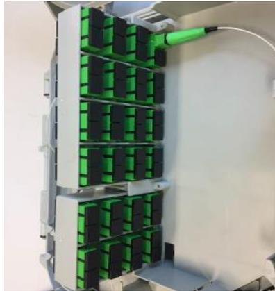
Disperdere l'extralunghezza di fibra del cavetto nella parte anteriore del modulo basculante come mostrato in figura.
