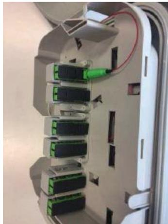
Disperdere l'extralunghezza di fibra del cavetto nella parte posteriore del modulo basculante come mostrato in figura.
