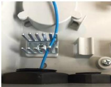
Selezionare la fibra del cavo multifibra in parcheggio o il cavetto singolo per la cessione della fibra di rete verticale e dopo aver seguito i percorsi già descritti nel 2.2.3.6 assemblare sulla fibra da terminare un connettore SC/APC montabile in campo e terminarla sul manicotto sul lato destro della rastrelliera di terminazione OLO.
