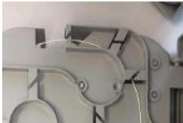
Assemblare sulla fibra da terminare un connettore SC/APC montabile in campo. Terminare la fibra sul manicotto SC/APC sulla rastrelliera di terminazione lato destro con un criterio di riempimento che va da destra verso sinistra e dal basso verso l'alto.
