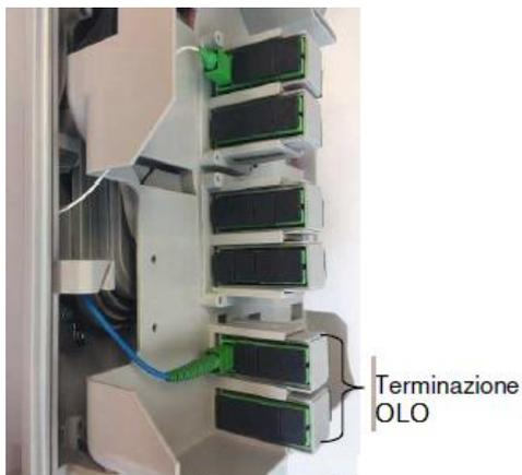
Una volta terminato il cablaggio fissare la bretella sull' imbocco utilizzando un giro di nastro adesivo in velcro e una fascetta in dotazione nel kit.
